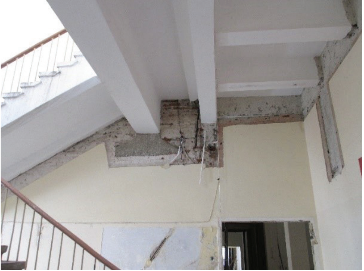
Fotoğraf 2: Kabataş Erkek Lisesi, Özgün duvar-Betonarme merdiven detayı, Saadet Mutlu Kaytan Arşivi, 2017.
