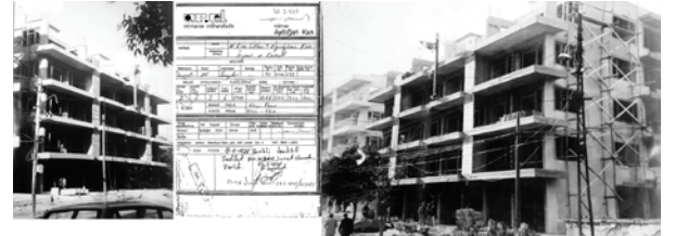
Resim 4: Apartmanların kaba inşaatları devam ederken. (Mimar Aydoğan Kan Arşivi)
