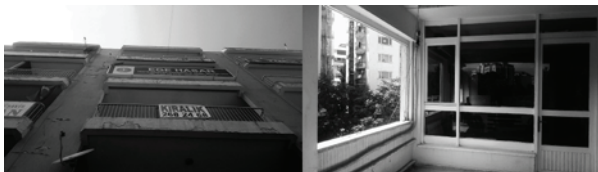
Resim 8: Gözde ve Cillov Apartmanlarına karakter veren yüzey / zemin ilişkileri (Kan Ülkü, 2018)
